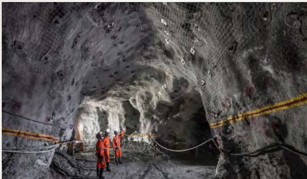
Reforço estrutural com concreto, tirantes e telamento
